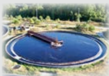
TRAITEMENT DES EAUX USÉES
